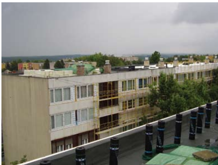
Paksi társasház szigetelése Zenit lemezzel
