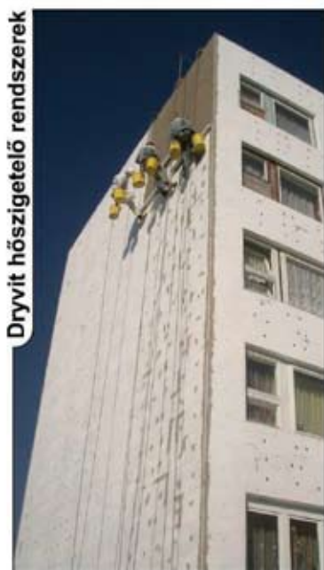
Panelhézag szigetelés
