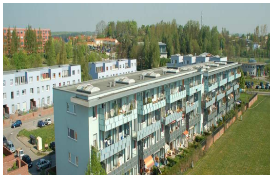
A földszinten privát előkertek, feljebb erkélyek hozzátoldása
