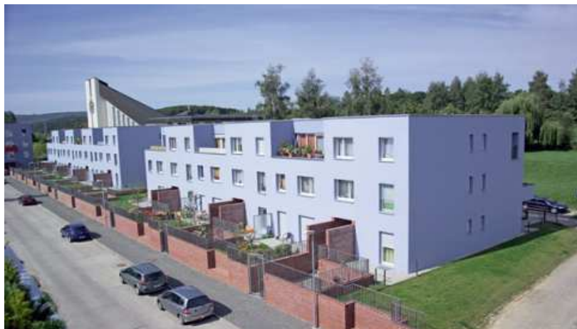
Panelrekonstrukció, Leinefelde, Németország
