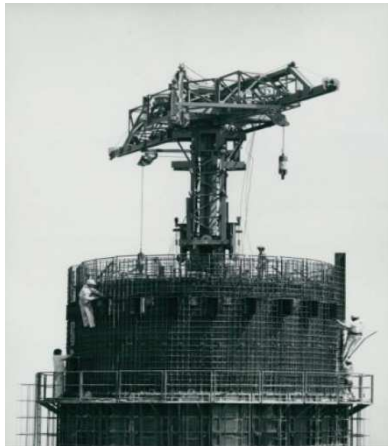
A Kékesi TV-torony építése Lechner Tudásközpont
